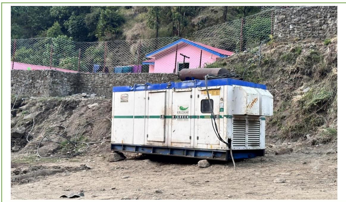
*Image 31: - 125kVA Diesel Generator*
